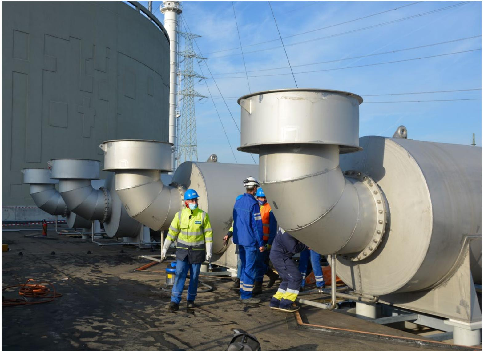
Placement des silencieux. Un coude, suivi d'un silencieux cylindrique Boet Stopson de type réactif, a été placé à l'embouchure des buses. Ainsi le rejet moteur est fortement atténué et dirigé en hauteur et vers l'intérieur du site de la Centrale, et non plus vers les zones d'habitat de Amay
