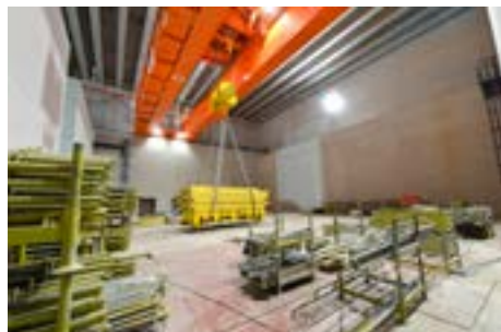
Le chantier du SF2 a débuté en 2020. En 2021, les grands travaux de génie civil ont été finalisés. En 2022, les composants, dont le pont de manutention des conteneurs, et les équipements intérieurs ont été installés.
