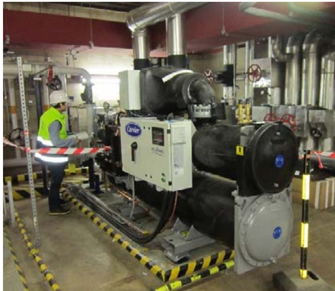
Installation d'un nouveau groupe de froid (CEG-Z05) sur l'unité 3 de la Centrale nucléaire de Tihange.
