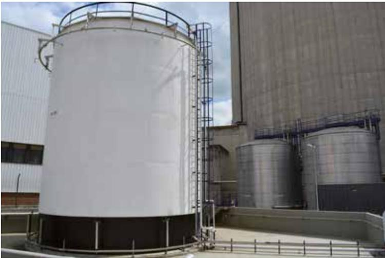
Les revêtements de surface des encuvements des réservoirs de fuel ont été complètement renouvelés pour garantir l'étanchéité parfaite de ceux-ci. La photo montre le réservoir principal de Ti1, 350 m<sup>3</sup>
