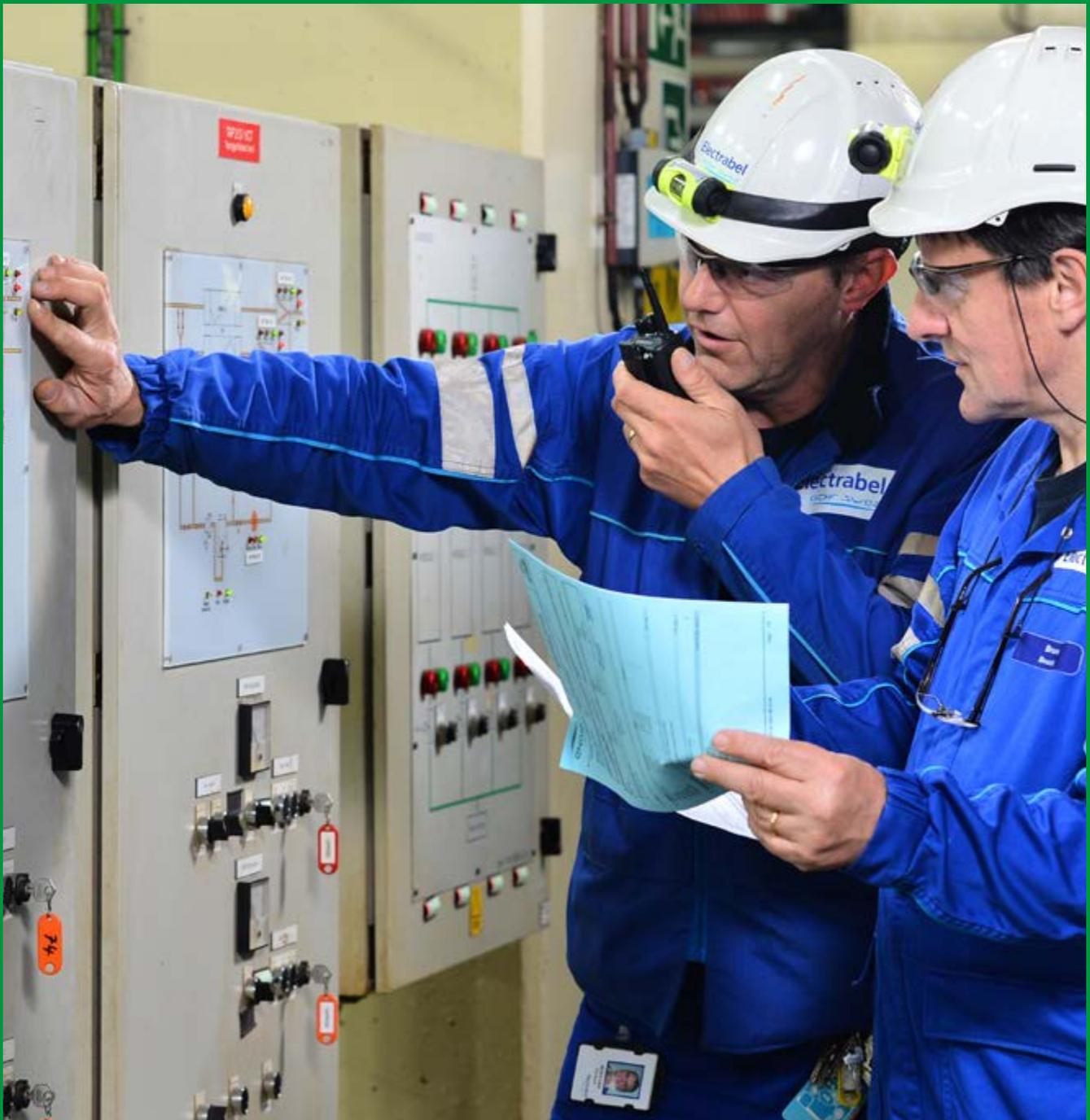
Deux techniciens réalisant la consignation de sécurité d'un tableau électrique.
