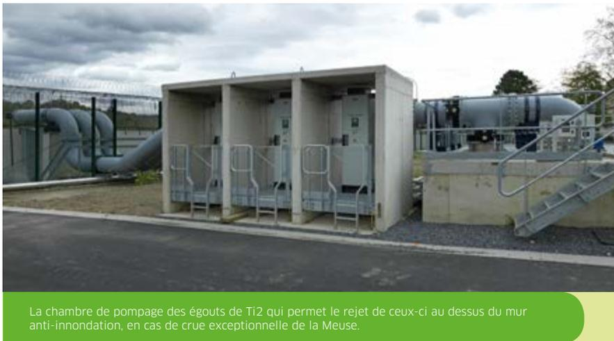
La chambre de pompage des égouts de Tihange 2 qui permet le rejet de ceux-ci au dessus du mur anti-inondation, en cas de crue exceptionnelle de la Meuse.
