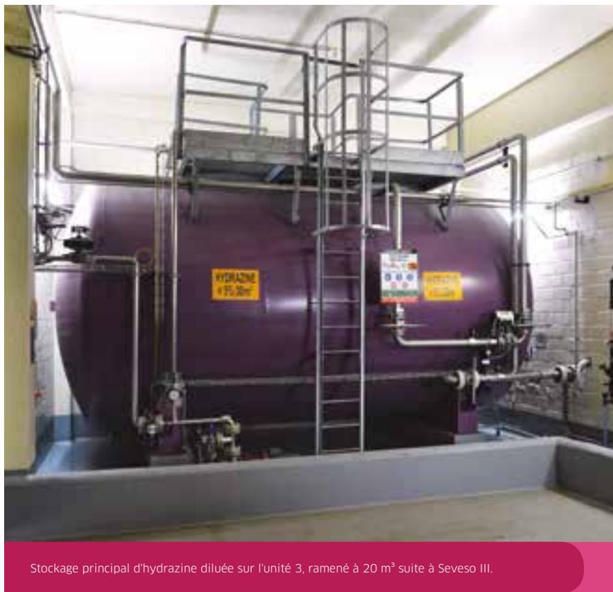
Stockage principal d'hydrazine diluée sur l'unité 3, ramené à 20 m<sup>3</sup> suite à Seveso III.
