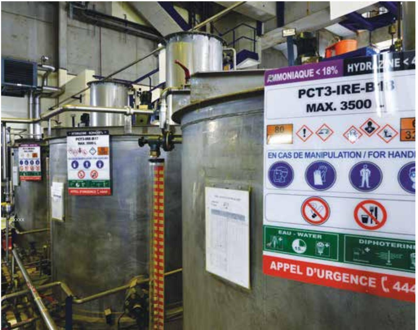
Installation de stockage et d'injection de réactifs chimiques en salle des machines de l'unité 3.
