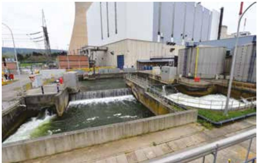
Vue de l'ouvrage de rejet de l'unité 3 dont les vannes barrages permettent la gestion des rejets thermiques conformément au permis d'environnement de la Centrale.
