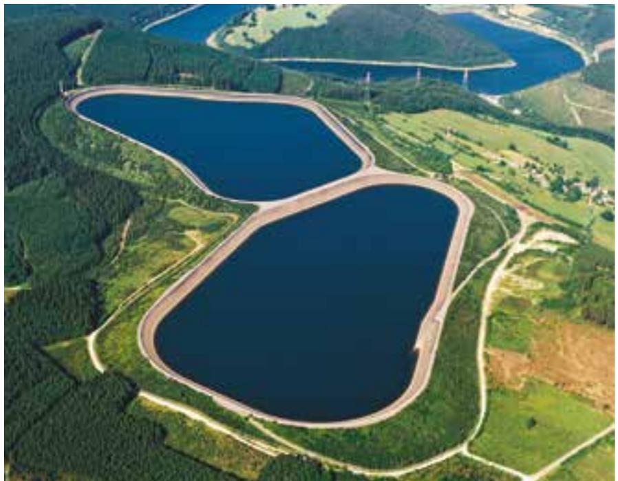
Centrale hydroélectrique (pompage-turbinage) de Coe qui permet de stocker l'énergie électrique.
