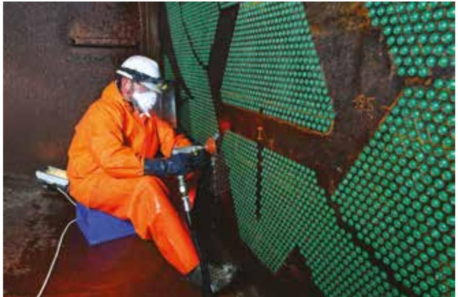
Nettoyage des tubes condenseur vu de l'intérieur d'une des 6 boîtes à eau. Cette dernière comporte 14.000 tubes d'échange de chaleur.
