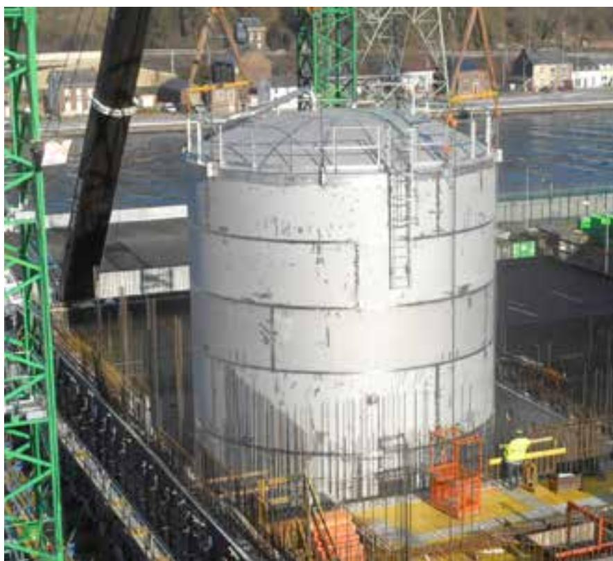
Manutention du nouveau réservoir d'une capacité de 800 m<sup>3</sup> d'eau alimentaire de secours dans le bâtiment d'ultime repli étendu de l'unité 1, bâtiment en construction.
