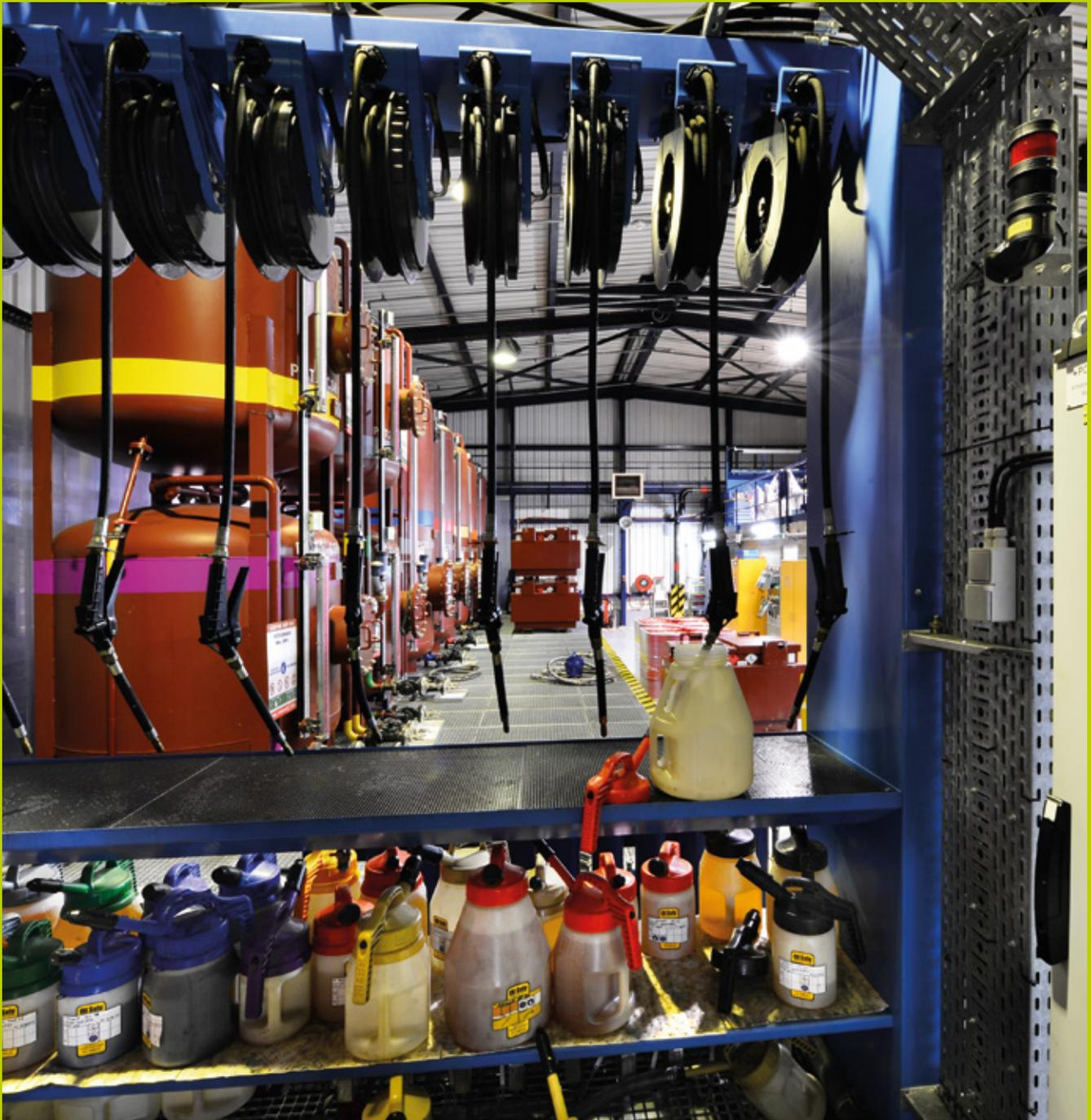
Vue intérieure de la huilerie centralisée. Une installation disposant des technologies les plus récentes en matière de stockage des huiles (garantie de qualité des lubrifiants, prévention anti-pollution, prévention incendie,...)
