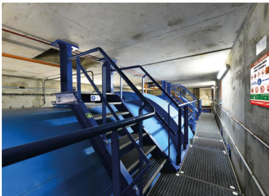
Réservoir de fuel de 170.000 litres servant à alimenter un groupe Diesel de secours. Ce stockage est placé dans un encuvement et fait l'objet d'une surveillance régulière des équipes de conduite.
