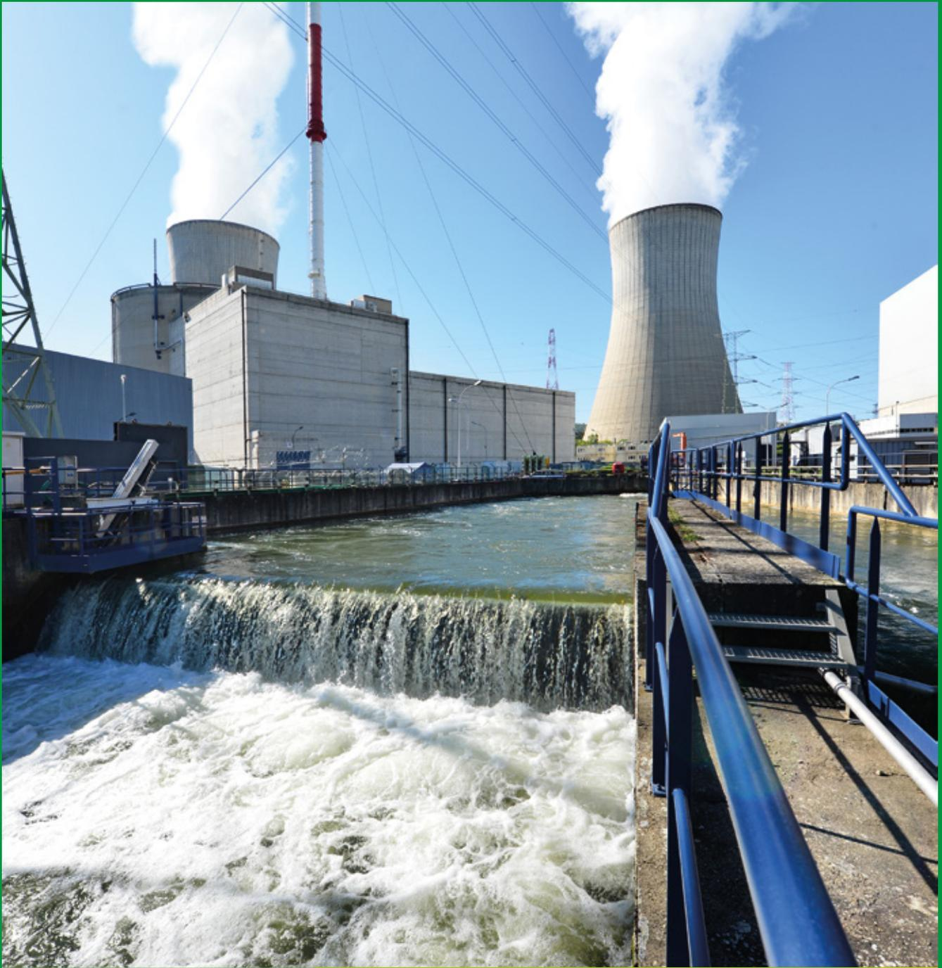
Vanne barrage de l'unité 2. Composante de l'ouvrage de rejet qui permet de réguler la quantité d'eau chaude rejetée en Meuse.
