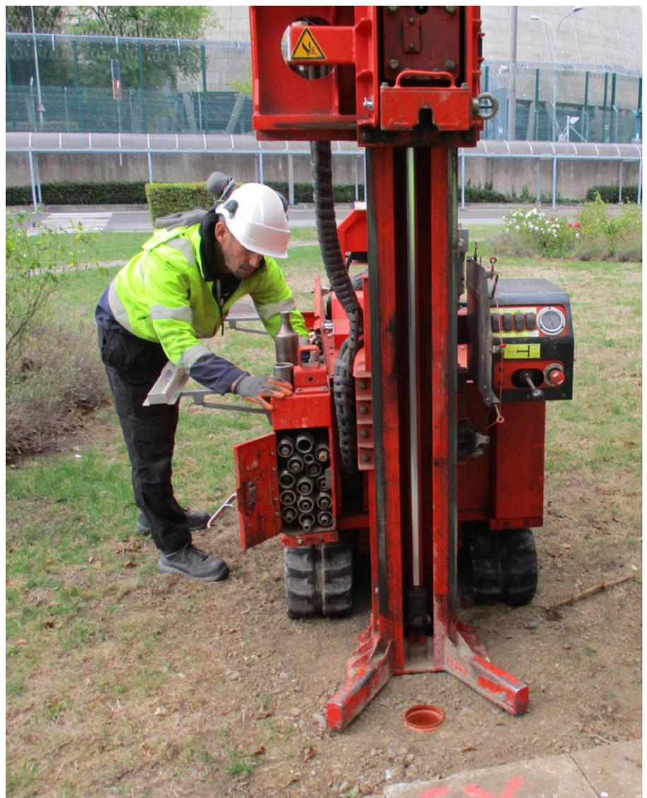
Réalisation d'un forage pour analyse de sol.
