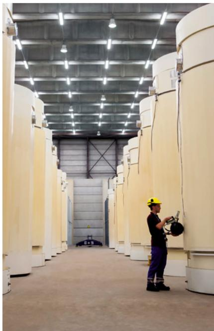
Entreposage à sec de combustible épuisé. Photo de l'intérieur du bâtiment existant déjà à la Centrale nucléaire de Doel.
