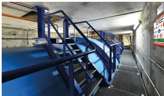
Réservoir de fuel de 170.000 litres servant à alimenter un groupe Diesel de secours. Ce stockage est placé dans un encuvement et fait l'objet d'une surveillance régulière des équipes de conduite.
