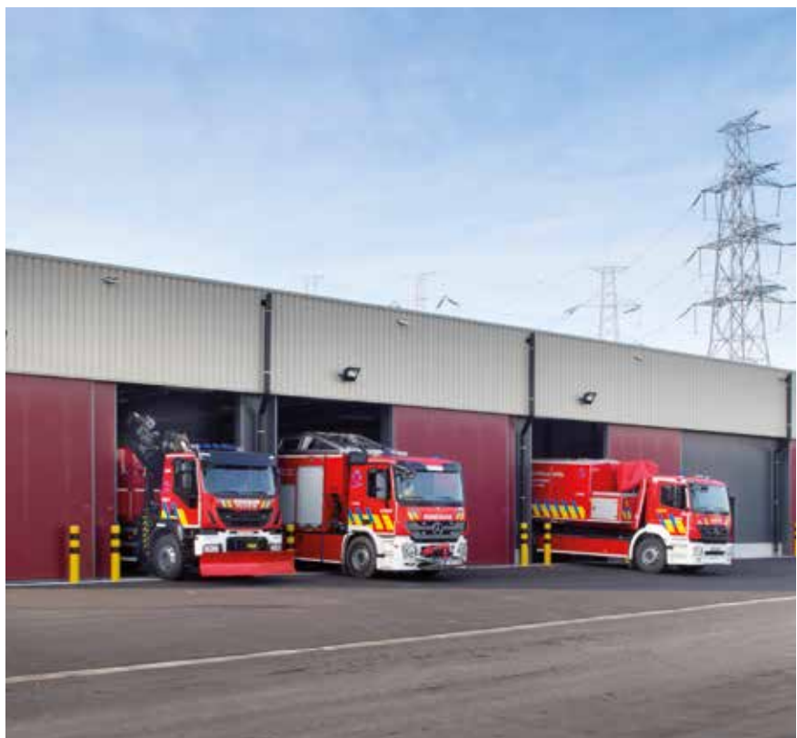
Gebouw Ultieme Middelen |
