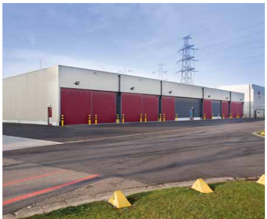
Gebouw Ultieme Middelen
