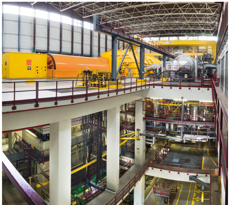
Machinezaal Doel 3 met alternator (oranje)
