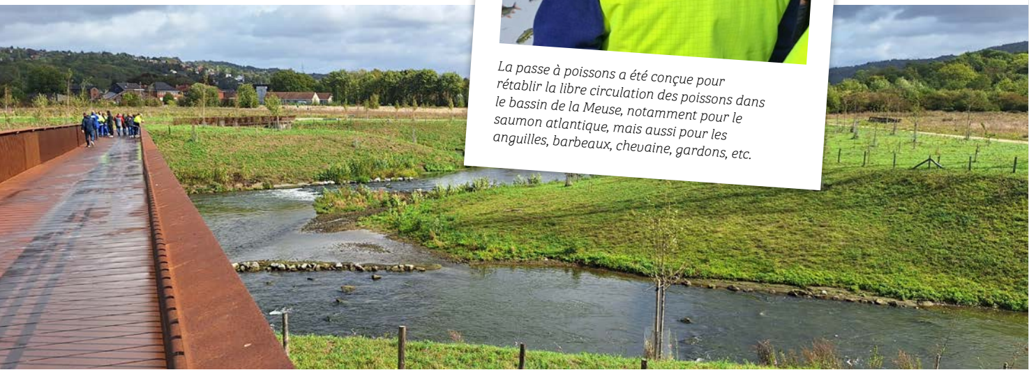
La nouvelle passe à poissons réalisée dans le cadre du chantier de mise à grand gabarit du site éclusier d'Ampsin-Neuville est une véritable rivière artificielle. Longue de 700m, il s'agit de la plus longue infrastructure de la sorte en Wallonie. Elle est composée de zones variées (mouilles, radiers, frayères) avec des profondeurs allant de 30 cm à 2 m, des courants de vitesses différentes et des substrats diversifiés (pierres, végétaux).
